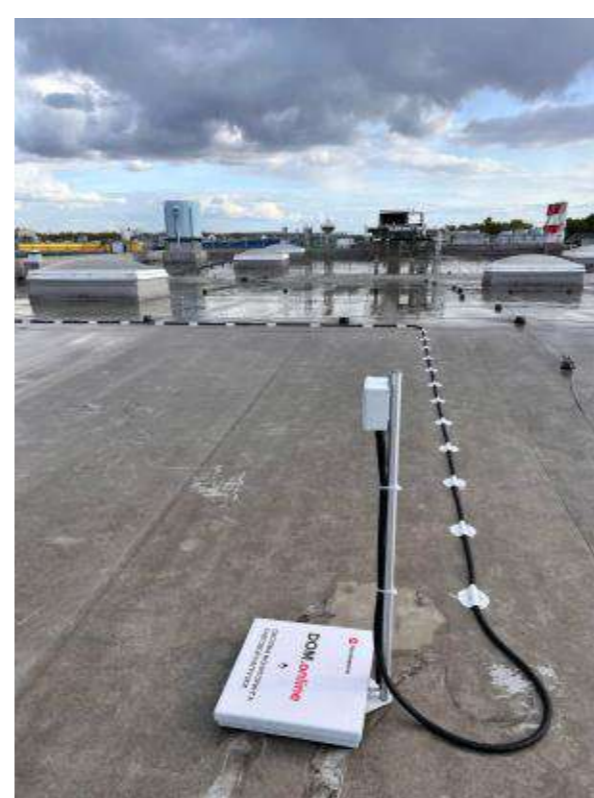
Рис. 5. Крепление трассы к ПВХ-мембране
